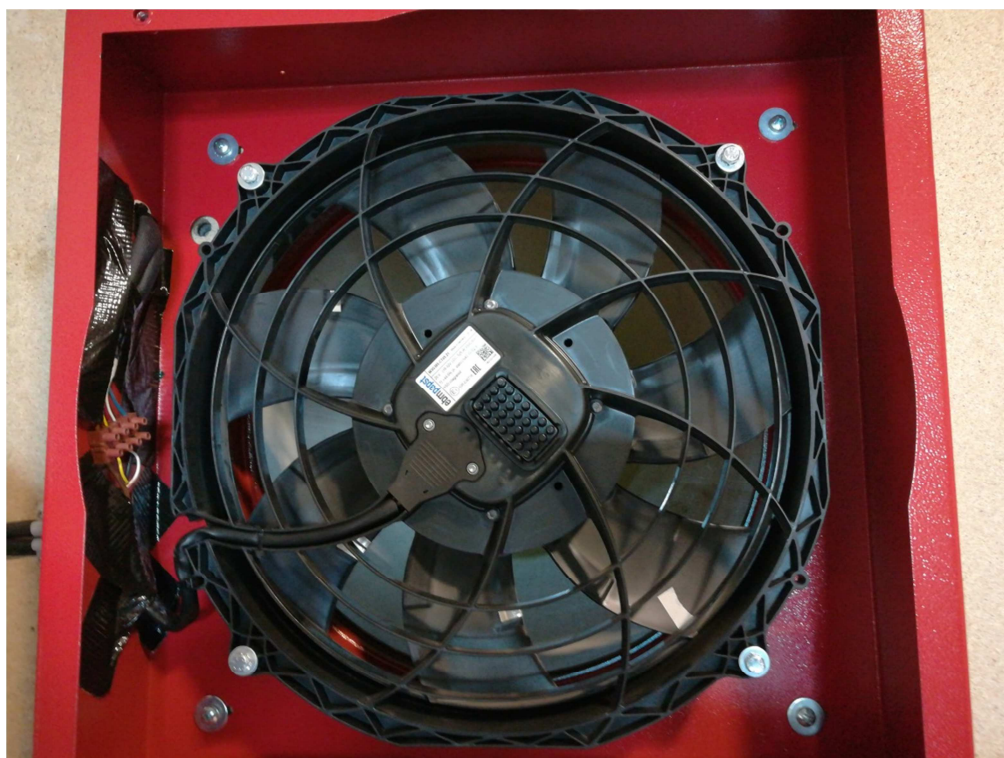
Fotografia dell'interno dell'unità di pressurizzazione
