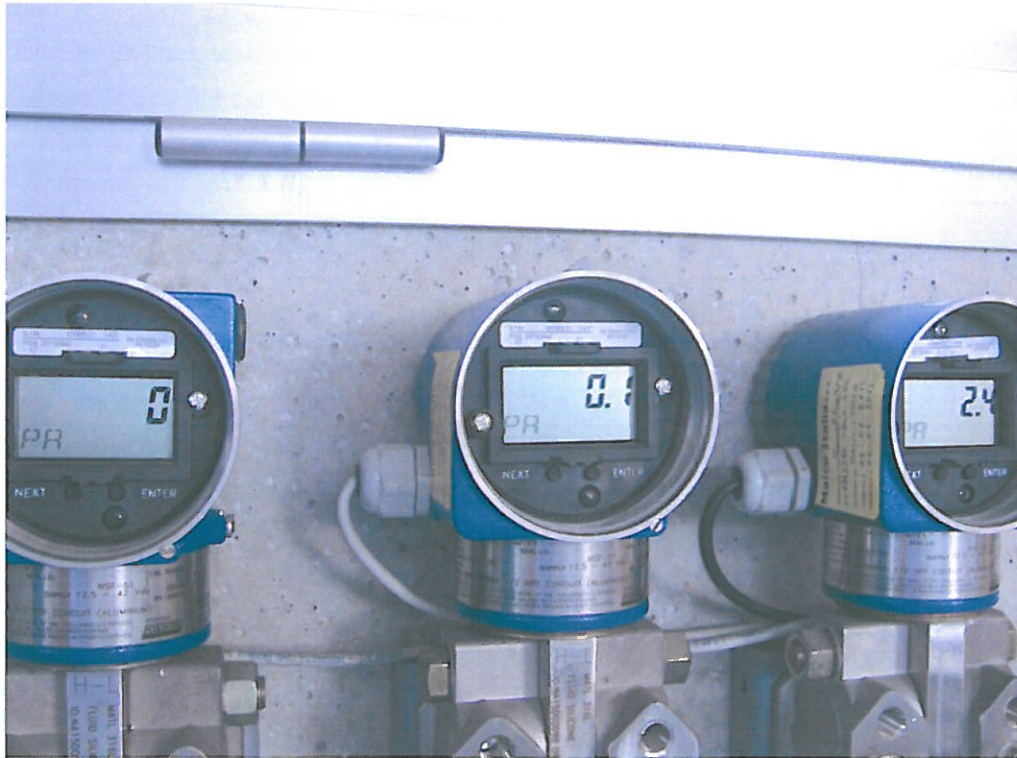
Fotografia dei tre trasmettitori di pressione differenziale modello “IGP20-A22A21D-M1K1”.
