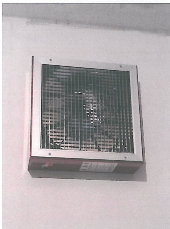
Fotografia dell'unità di pressurizzazione.
