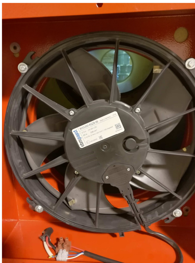
Fotografia dell'interno di una elettroventola assiale dell'unità di pressurizzazione
